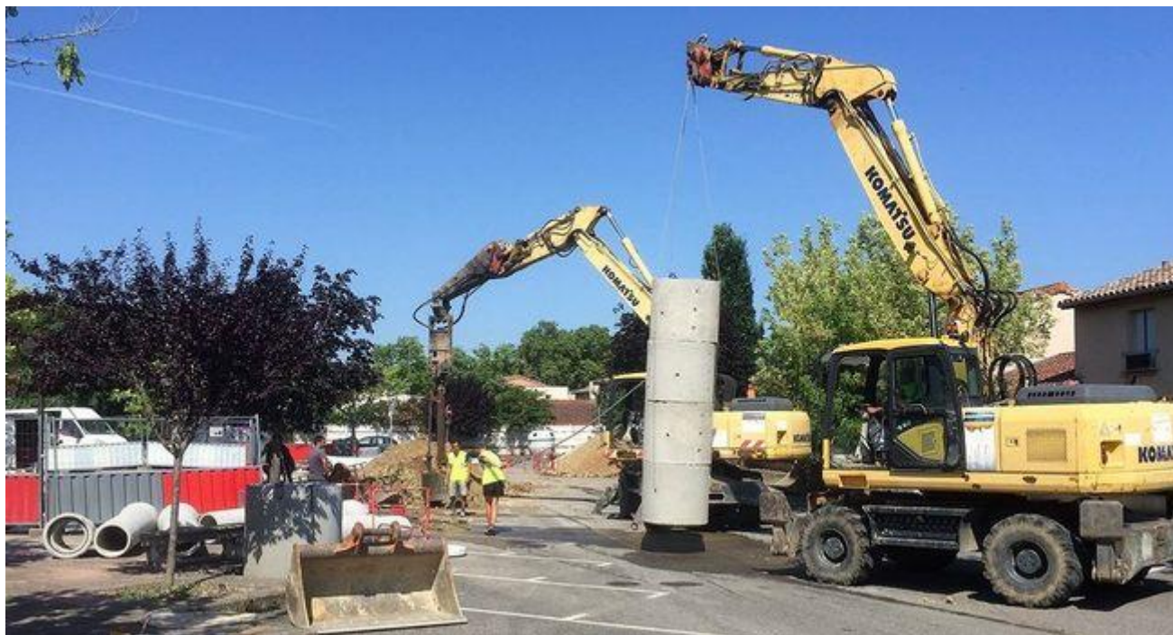
Importants travaux pour limiter les inondations.
